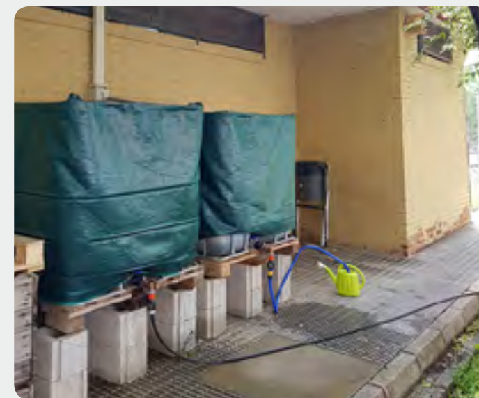
Depósito de aguas pluviales conectado a bajante del edificio.
