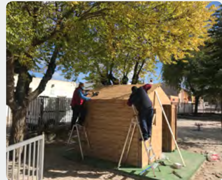
Seguimiento de la construcción de la caseta bioclimática instalada en el patio a cargo de la empresa local contratada.
